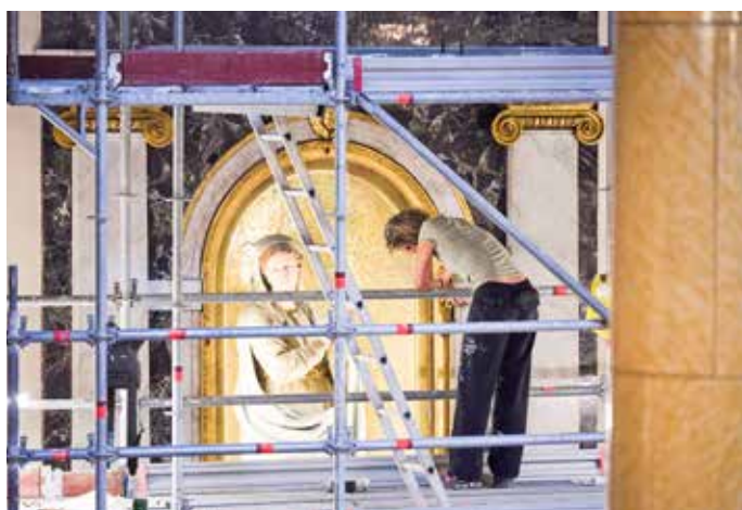
I lavori alla cappella della Beata Vergine Immacolata
