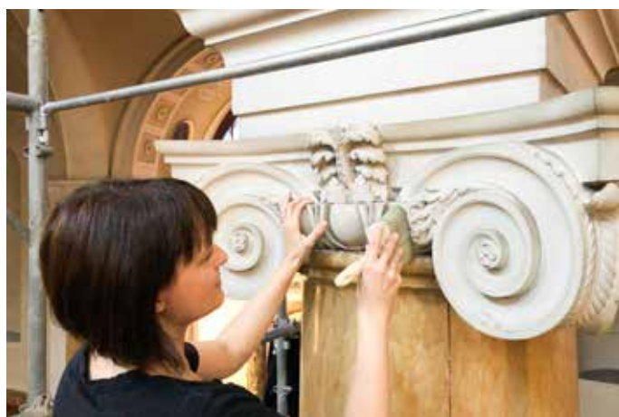
Il lavoro di ripulitura di uno dei capitelli delle colonne
